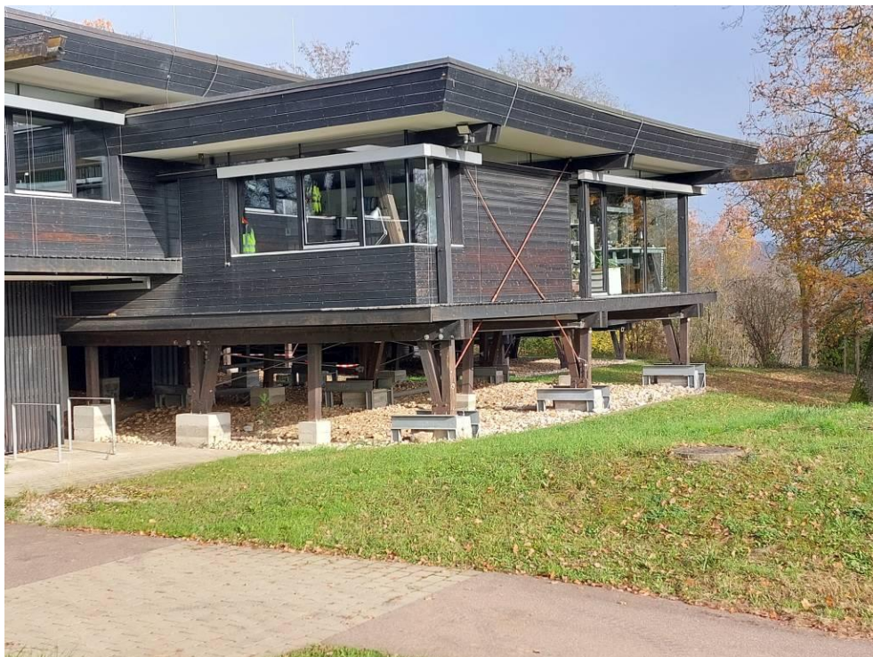
Abb. 9: Holz-Bungalow-Gebäude auf Stelzen
