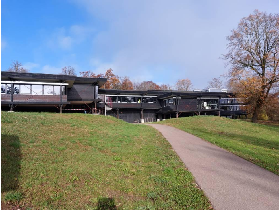
Abb. 8: Bungalow-artige Gebäudeteile Frontseite
