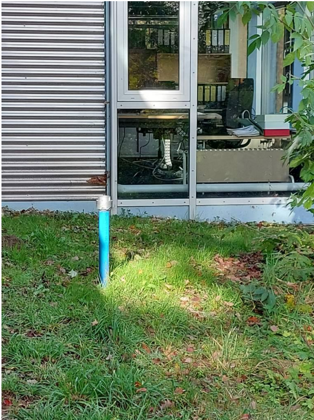
Abb. 11: Radon-Bodenluftsonde vor einem verglasten Büro
