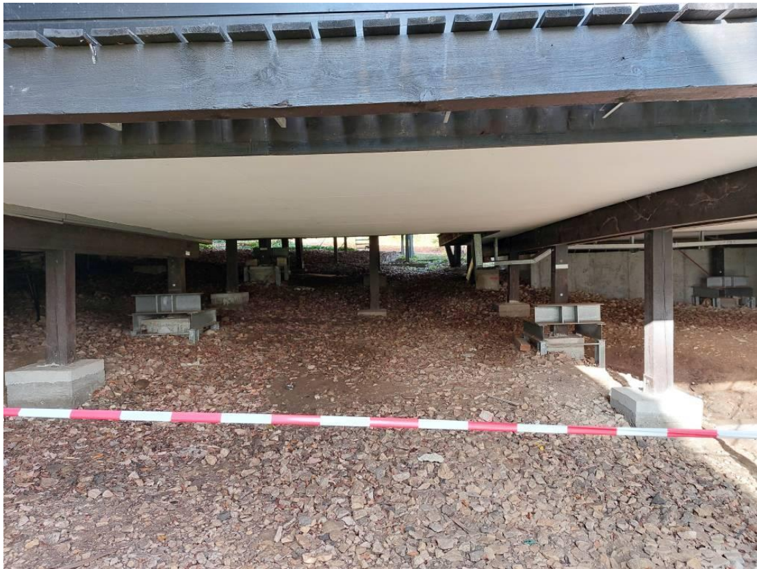
Abb. 10: Blick unter einem Bungalow-Gebäude zwischen den Stelzen hindurch
