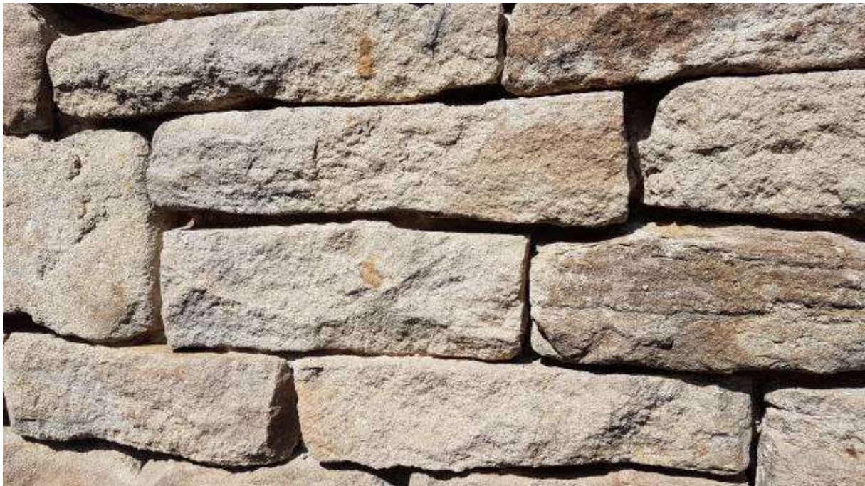
Abb. 10b: Mauersegment aus der „strahlenden Kapelle“, welches den uranimprägnierten Sandstein deutlich zeigt, der für Kapelle und Mauer verwendet wurde
