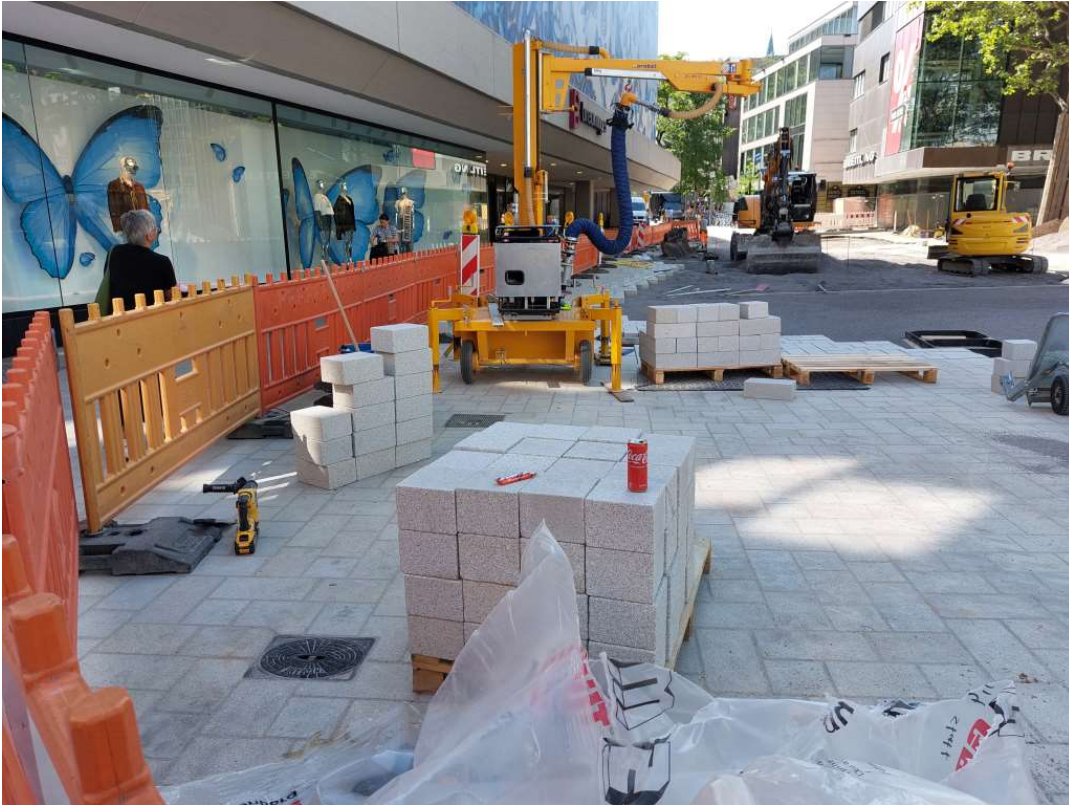
Abb. 2: Vor dem Breuninger Kaufhaus ist man in den letzten Zügen mit dem Verlegen der Granitsteine
