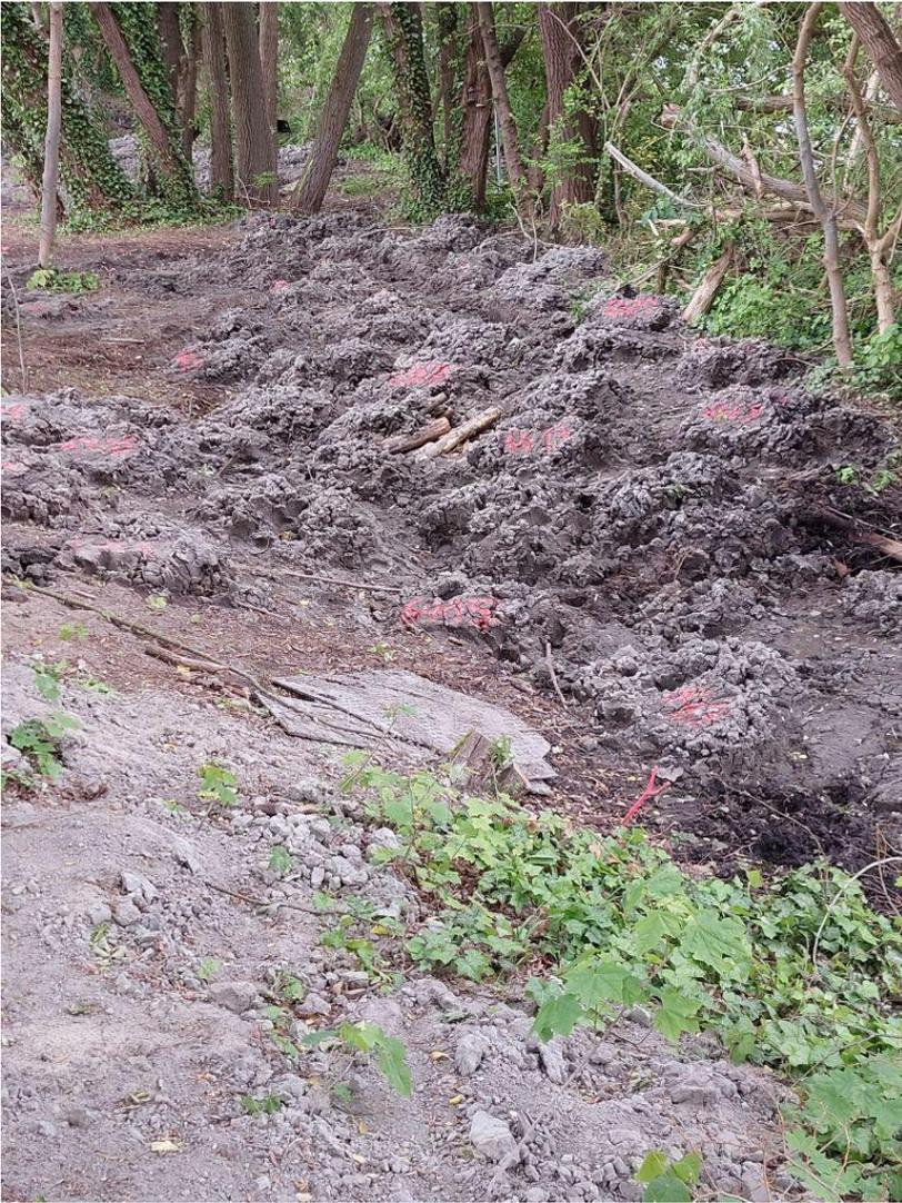
Abb. 13: Mit Sprühfarbe angebrachte Markierungen des aufgebaggerten Bodens südlich des Fußballplatzes im Bereich des Hotspots
