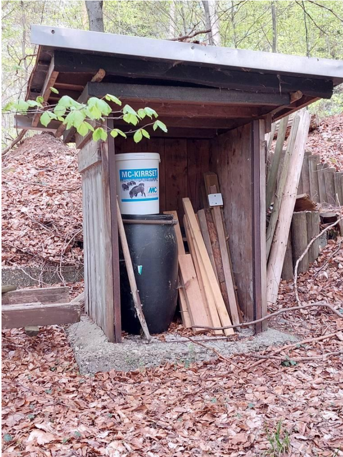
Abb. 29: Der Jagd-Schuppen am Eingang zum Schürhau-Steinbruch
