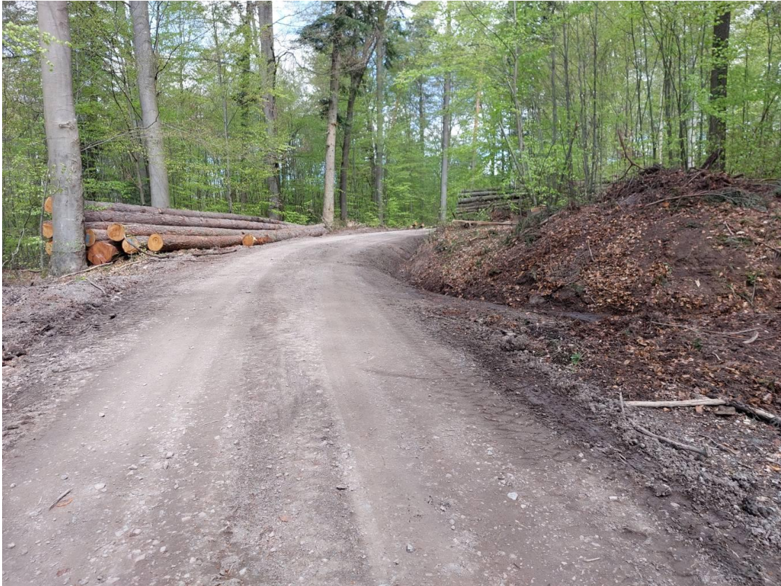
Abb. 27: Das Schürhaubrunnensträßle am Abzweig zum Steinbruch (N48.98542° E9.48756°), der Schotter ist vom grauen Sandstein bzw. rötlichen Tonstein gefärbt
