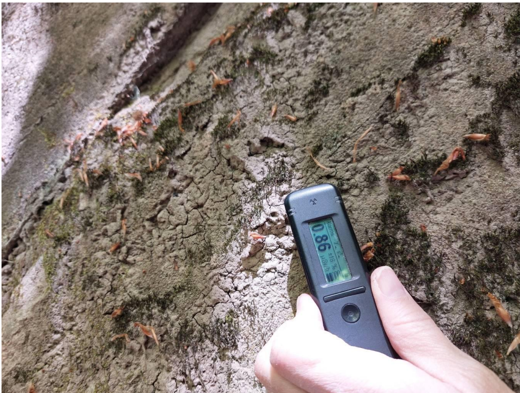
Abb. 10: Messung an der Fleins-Wand im nördlichen, hinteren Teil des Steinbruchs
