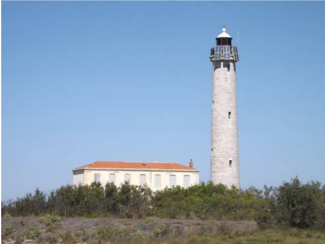
Abb. 15: Der Leuchtturm von Beaduc "Remote Controlled" und von Solarzellen gespeist
