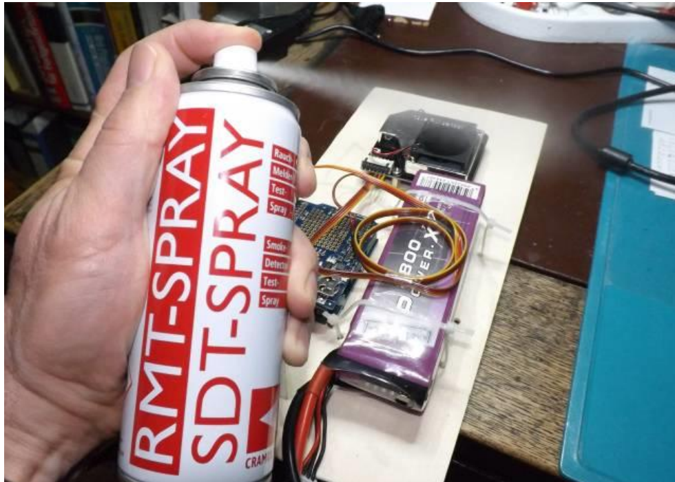
Abb.1: Anwendung eines Rauchmelder Testsprays
